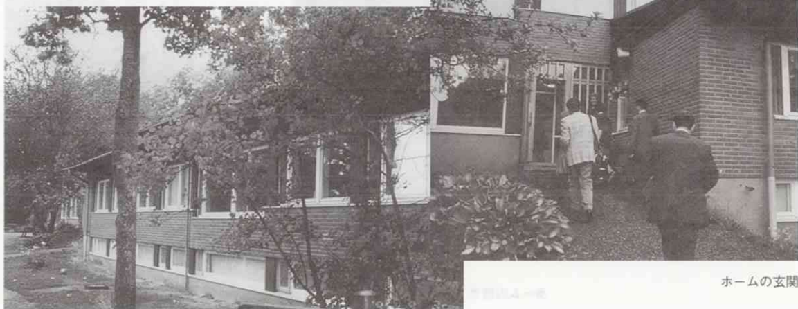
レセプションホームの外観
